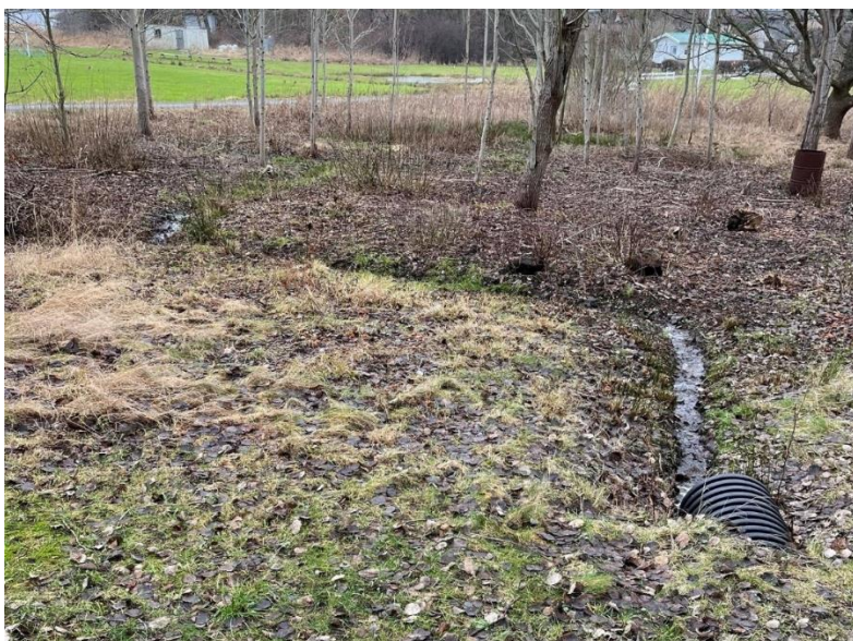
Figur 5. Tillrinning via trumma för område C.
