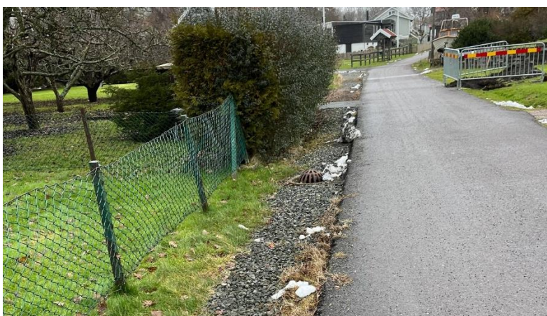
Figur 6. Makadamdike i Källdalsvägen.
